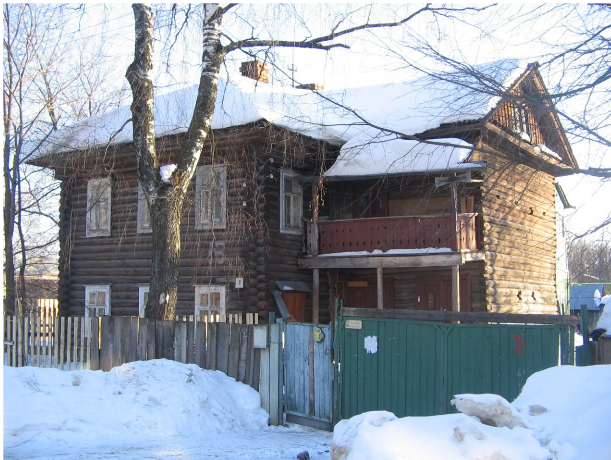
Дом по ул. Гоголя 18:
