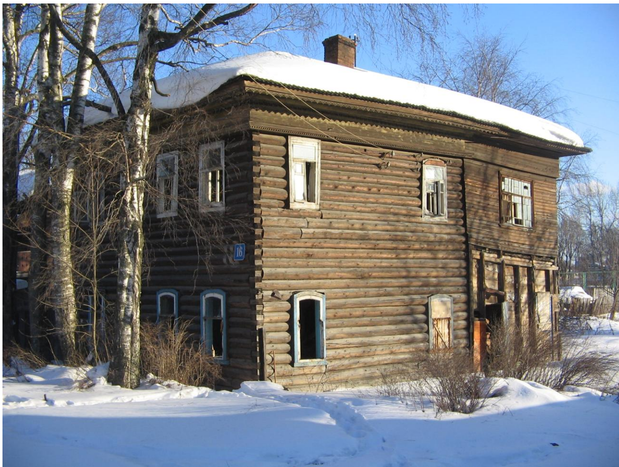
Дом по ул. Гоголя 16:
